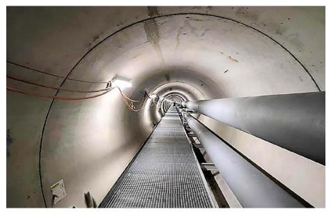
■ Die neue Fernwärmeleitung in den Dimensionen DN200 bis DN500 wird auf 2,5 km Länge im bestehenden Energiekanal, auf ebenfalls 2,5 km im neuen Microtunnel-Stollen und auf 1 km erdverlegt. (Bild: ERZ)
